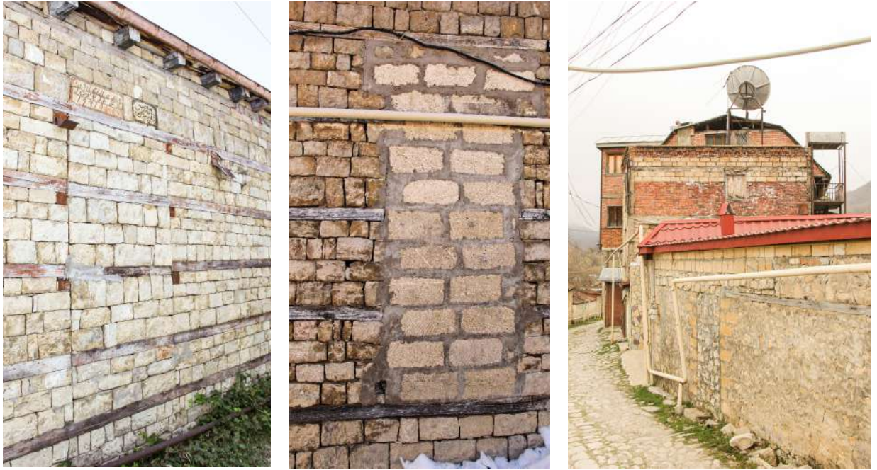
Şəkil 3.27 Nəzarətçi məmurlardan yayınmaq üçün istifadə edilən əlavə çıxış və ya qaçış qapıları.
