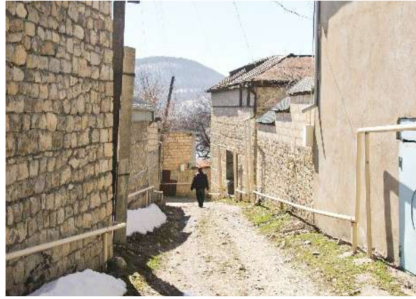
Şəkil 2.26 Solda ənənəvi tikinti materialı, sağda suvanmış və ənənəvi görüntüsü olmayan ev fasadı olan küçə
