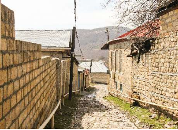
Şəkil 2.25 Bir tərəfi mişar daşından, digər tərəfi ənənəvi tikinti materialından istifadə edilmiş ev fasadı olan küçə
