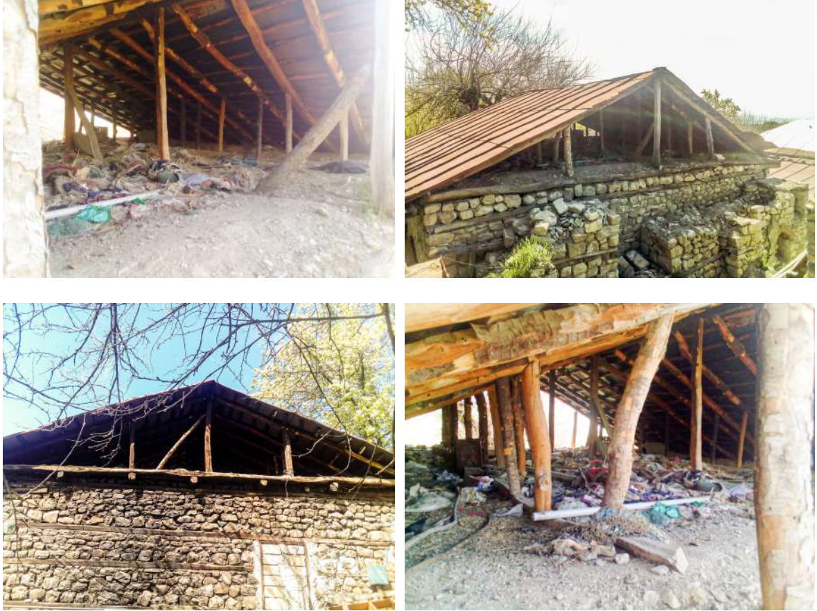
Şəkil 3.35 Bir tərəfi açıq dam-çardaqlar
