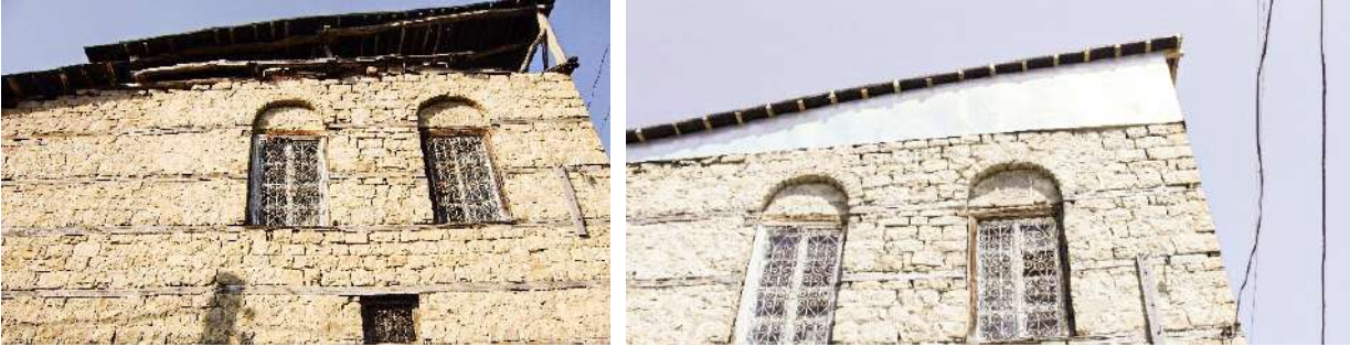
Şəkil 3.25 Dəmir lövhələrin üstünün ağac materiallarından hazırlanmış hörməçəpər elementlərlə işlənməsi tövsiyə olunur
