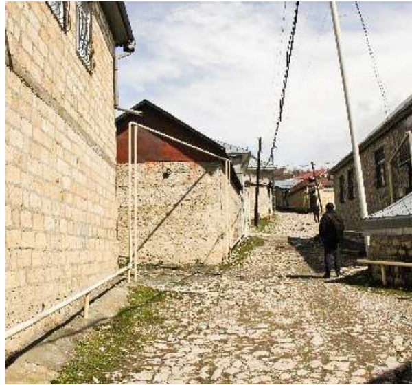
Şəkil 2.28 Demirçibazar küçəsindəki bu evin fasadı ənənəvi görüntünü pozur.
