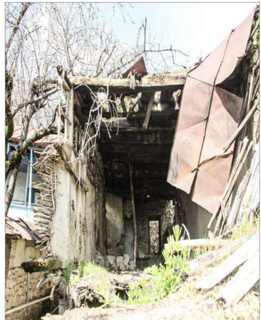
Şəkil 3.60 Bağdadi üsul ilə tikilmiş ev divarı
