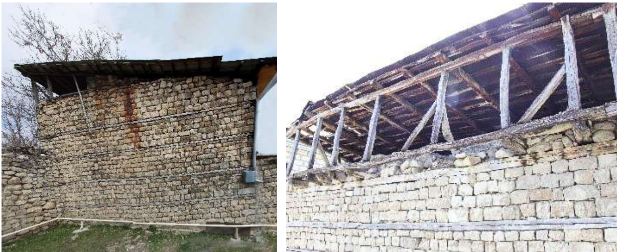
Şəkil 3.24 Fəza mühütində buxarıdan çıxan tüstü rahat diffuziya ola bilər və təbii antiseptik tədbir kimi ağacdan konstruksiya elementlərin fumiqasiya olunmasına şərait yaradırdı.
