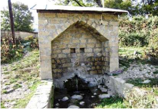
Şəkil 2.48 Qədim dövrlərdən işlək olmuş Pahpahı bulağı mişar daşından istifadə edilməklə bərpa edilmişdir və qədim görünüşünü itirmişdir.
