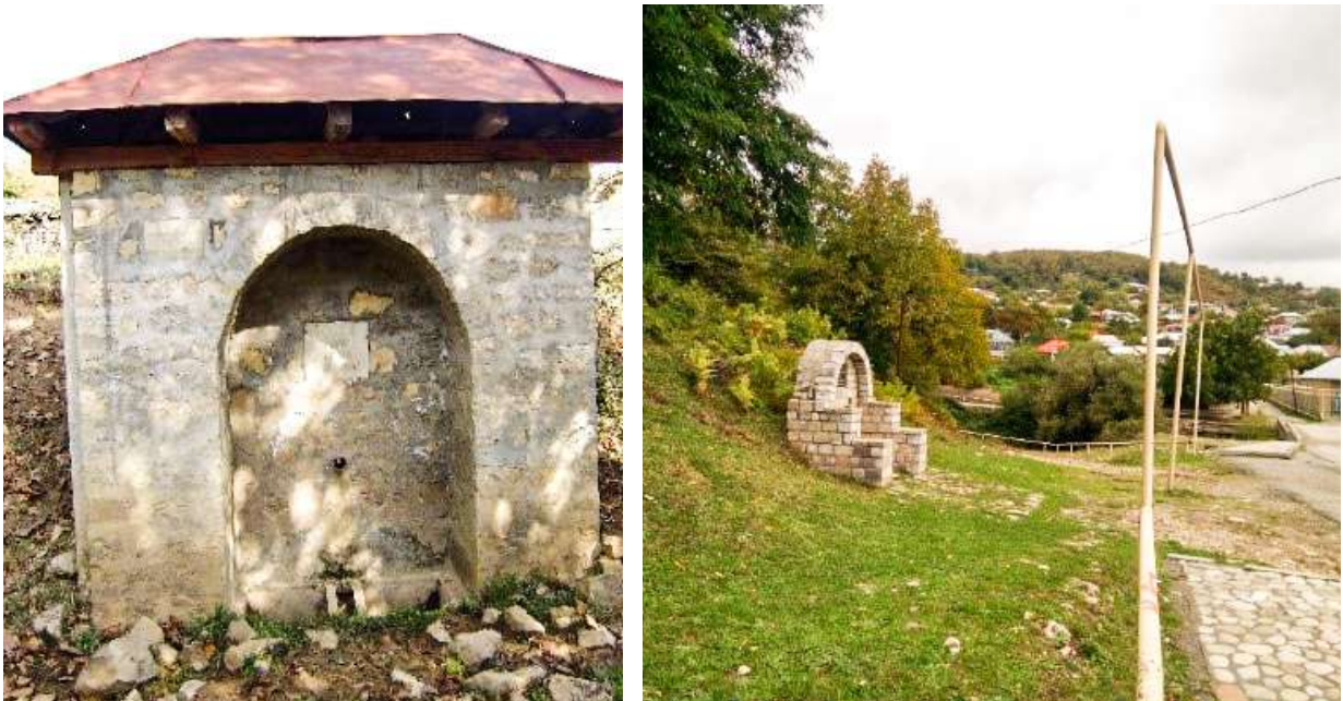
Şəkil 2.51 Yeni tikilmiş bulaqlar
