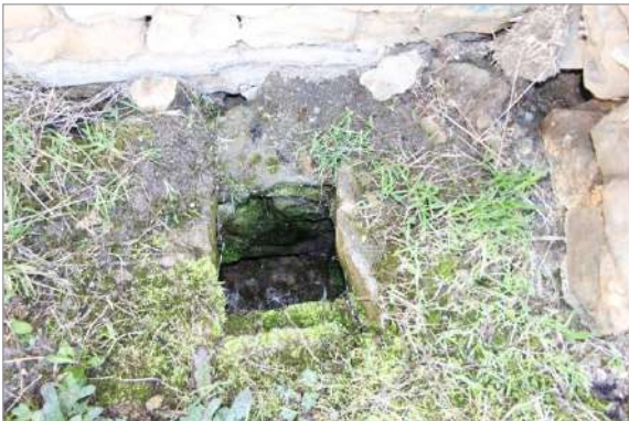
Şəkil 2.53 Kürəbənd şəbəkəsinin Qəlibgah məhəlləsindəki həyətlərdən birində üzə çıxmış hissəsi
