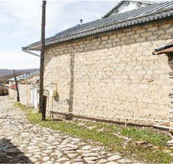
Şəkil 2.27 Mişar daşından tikilmiş ev fasadı
